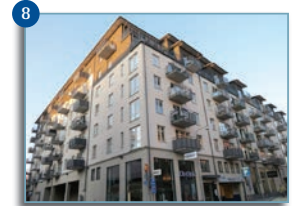
Objekt: Kv. Repslagaren 26 Adress: Nygatan 35 Best.: L G Söderbergs Projekt AB Modell: Haga Antal: ca 570 År: 2007
