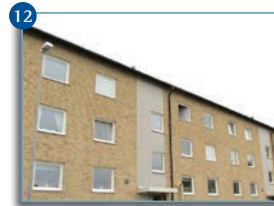
12 Objekt: HSB Brf. Nr. 40 Tiunda Adress: Norrlandsgatan 42 Best.: Fönsterspecialisten CG AB Modell: Epok Antal: ca 340 År: 2010
