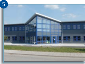
Objekt: Kv. Ventilen 6 Adress: Topplocksgatan 4 Best.: Byggmästarn i Skåne AB Modell: Standard Antal: ca 70 År: 2008
