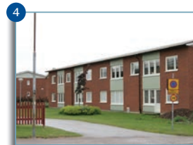
4 Objekt: Brf. Körveln Adress: Kummingatan 9 Best.: Jonny Olssons Fönster & Bygg i Enköping AB Modell: Haga Antal: ca 1900
