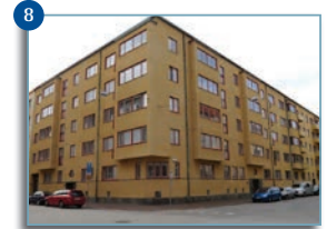
Objekt: Guvernören 5 Adress: Erik Dahlbergsgatan 17 Best.: K-Fasader Modell: Epok Antal: ca 200 År: 2009
