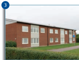
3 Objekt: Brf. Kvannen Adress: Körvelgatan 13 Best.: Jonny Olssons Fönster & Bygg i Enköping AB Modell: Haga Antal: ca 1600
