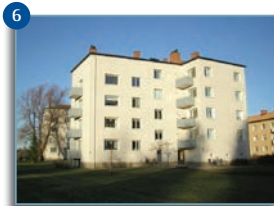
6 Objekt: Brf. Kurvan Adress: Tiundagatan 51 Best.: Valbo Fönster- teknik AB Modell: Epok Antal: ca 1000 År: 2008-2009
