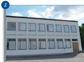
Objekt: Stålforskskolan Adress: Gillbergavägen 5 Best.: Enebo Mark & Bygg AB Modell: Haga Antal: ca 300 År: 2008
