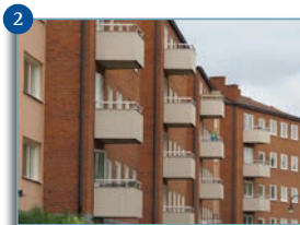
2 Objekt: Brf. Västerborg Adress: Stigbergsgatan 7 Best.: Jonny Olssons Fönster & Bygg i Enköping AB Modell: Haga Antal: ca 450
