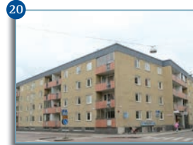
20 Objekt: Brynhild A-F Adress: Kungsängsgatan 36 Best.: Fönsterbyte / Byggrossisten Modell: Haga Antal: ca 400 År: 2008
